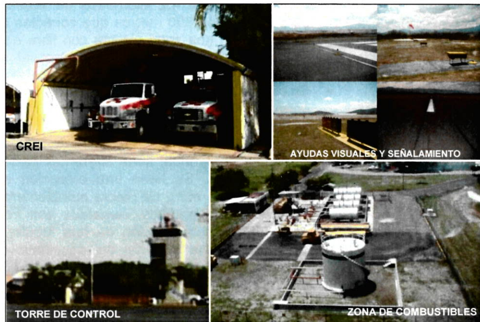
Figura 2.8 Algunas de las instalaciones complementarias de apoyo.
