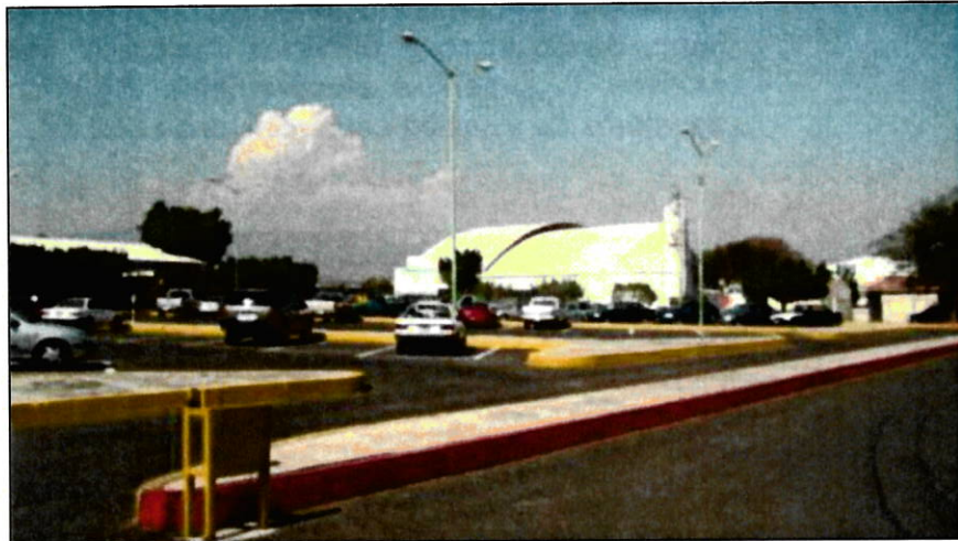
Figura 2.10 Zona de estacionamiento.
