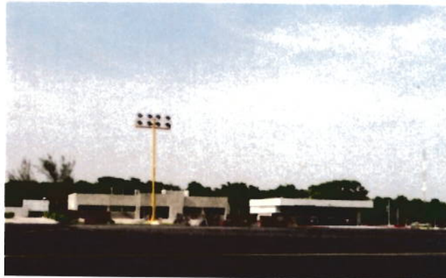
Camino de acceso a la emergencia.
