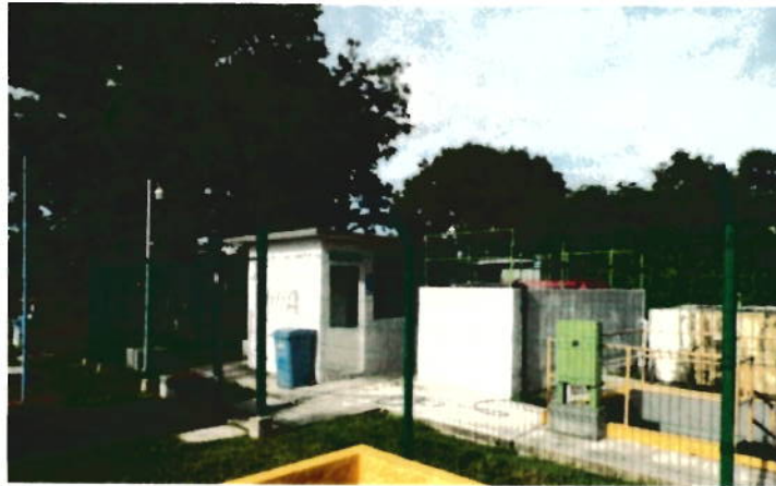
Planta de Tratamiento de Aguas residuales
