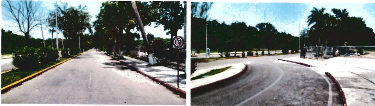
Camino de Acceso
