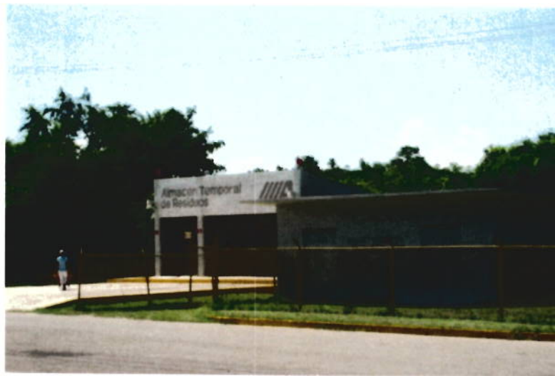
Almacén Temporal de residuos
