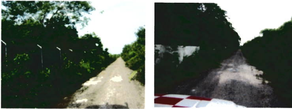
Caminos perimetrales. Malla metálica y barda de concreto.
