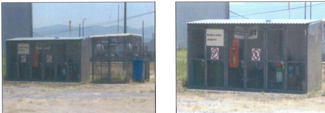
Almacén temporal de residuos peligrosos
